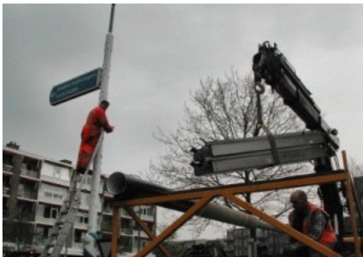
Montage van Lichtwegwijzers
