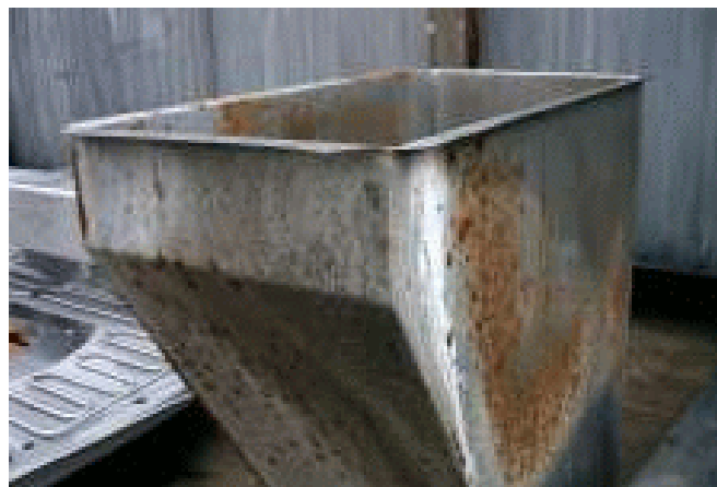
Door ijzeroxide aangetaste kap (foto: Vecom, Maassluis).
